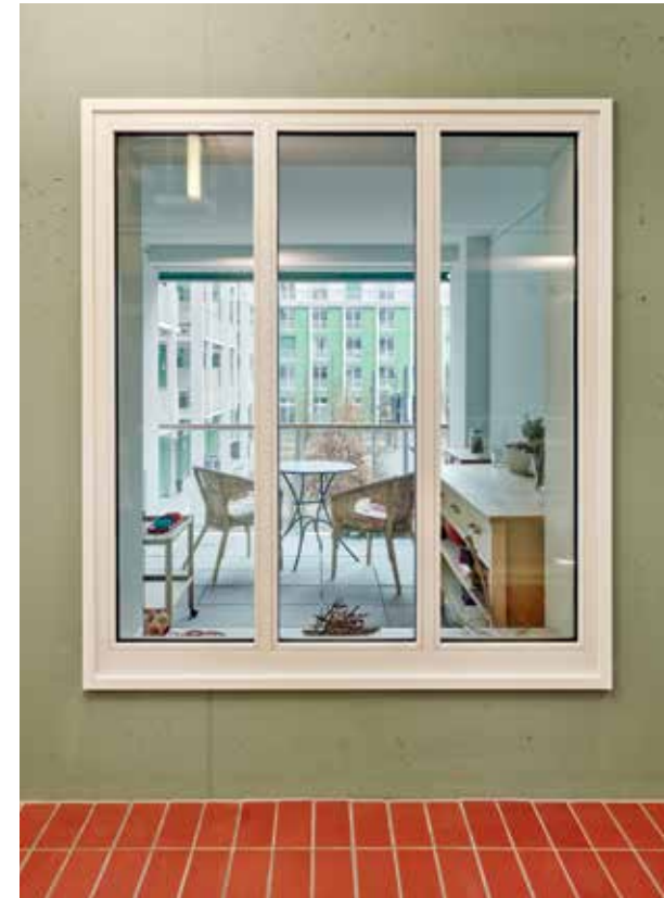
Wohnungsfenster im Atrium
