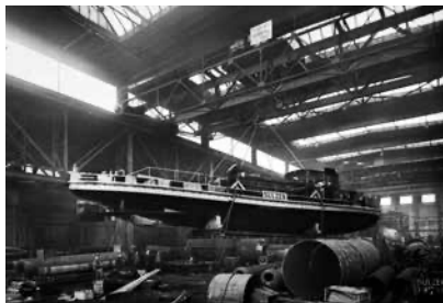
Firma Sulzer, Halle 180: Feuerlösch- und Bergungsboot St. Florian für die Stadt Basel, 1940
