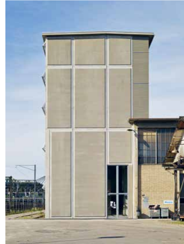
Stirnfassade der aufgestockten Halle 181 am Lagerplatz
