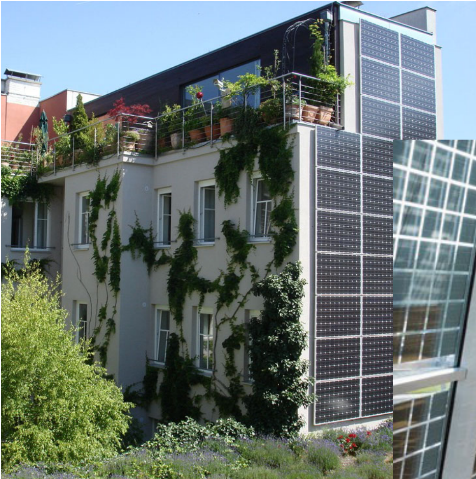
Solarfassade Boutique Hotel Stadthalle
